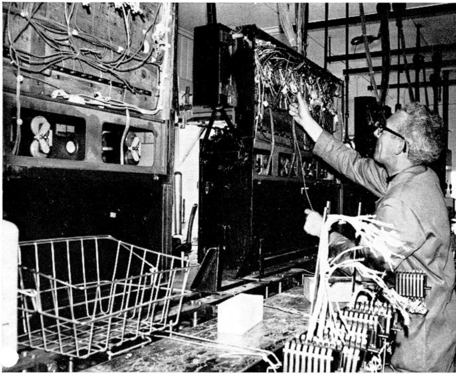
Linksboven: De aansluitblokken van de ascontacten werden tevoren op een plank afgemonteerd en tijdelijk achter het HSM-toestel aangebracht.
