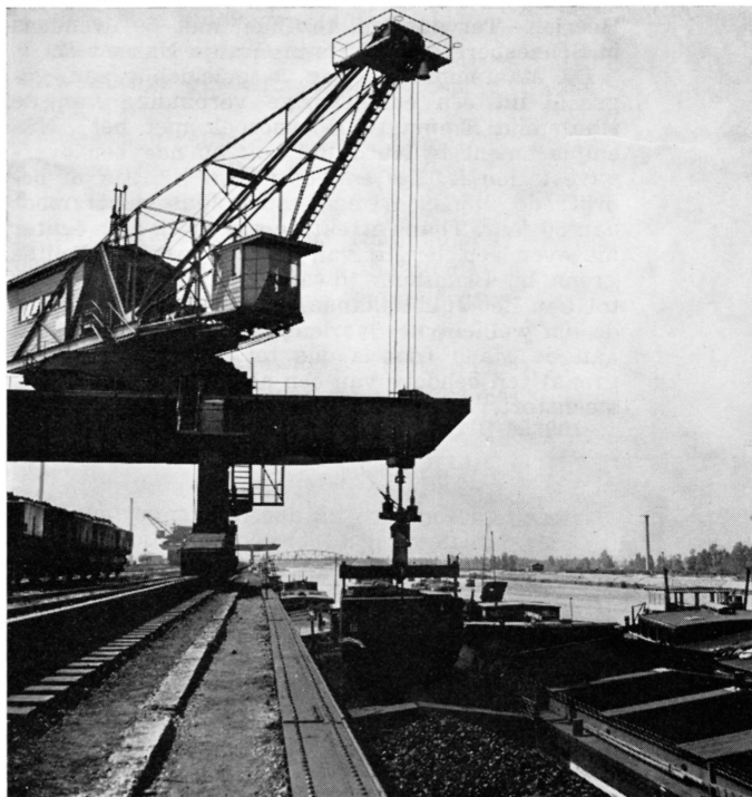
Lossen van bak met cokes in schip te Stein Foto Staatsmijnen
